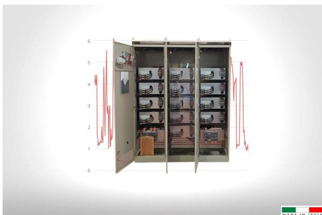
I rifasatori della serie **AAR/600** sono particolarmente indicati per reti trifase con **altissimo contenuto armonico**. Queste apparecchiature garantiscono un accurato rifasamento, grazie ad una logica multi gradino che ne fraziona efficacemente la potenza. Inoltre, sui quadri di tipo G6E e G8E, tutti i componenti delle batterie sono assemblati su cassette, facilmente estraibili dal fronte del quadro, per una semplice gestione e manutenzione.
