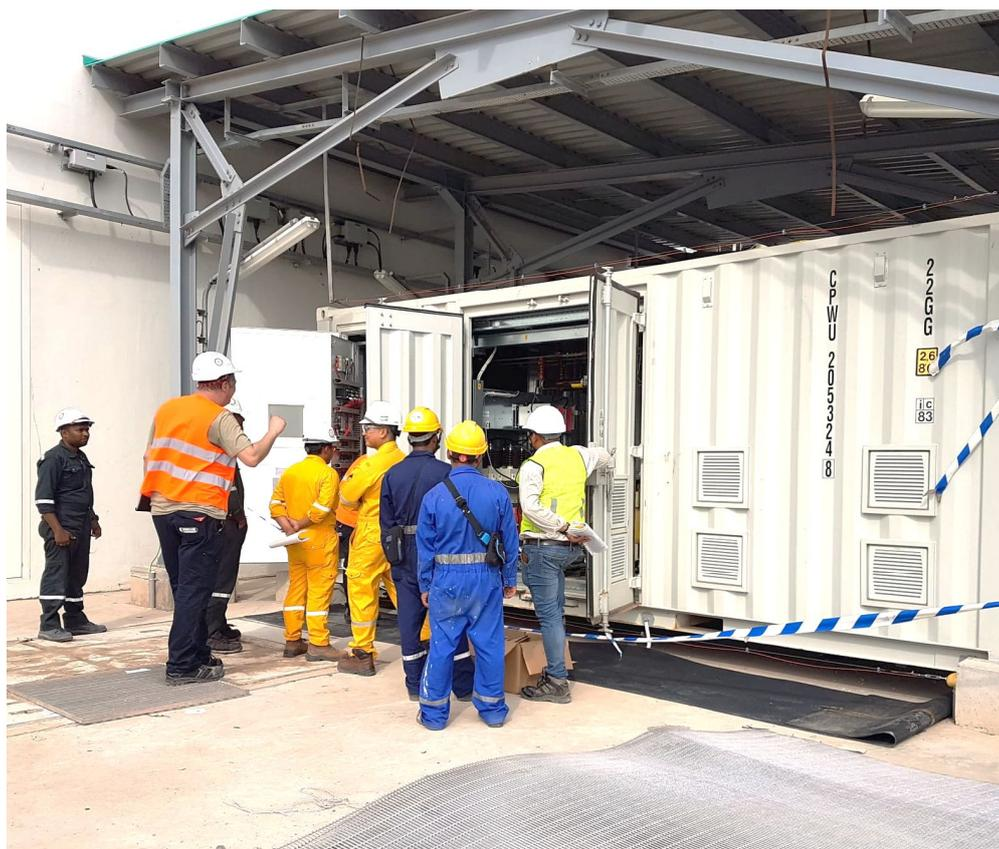
Difatti, l'installazione in container permette di **ridurre i tempi di messa in servizio**, in quanto è possibile posizionare l'apparecchiatura direttamente sul basamento al suo arrivo in cantiere, così come i costi di noleggio delle apparecchiature di sollevamento necessarie allo scarico ed al posizionamento.
