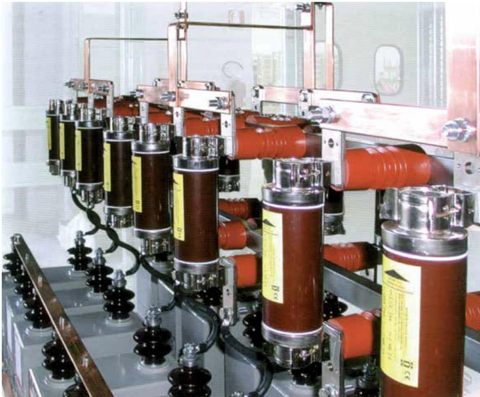
I fusibili di espulsione sono normalmente usati per proteggere i banchi con alte potenze solitamente installate all'esterno, dove ci sono molte unità in parallelo. L'utilizzo di fusibili di espulsione è un sistema pratico, economico e funzionale poiché, in caso di guasto:
