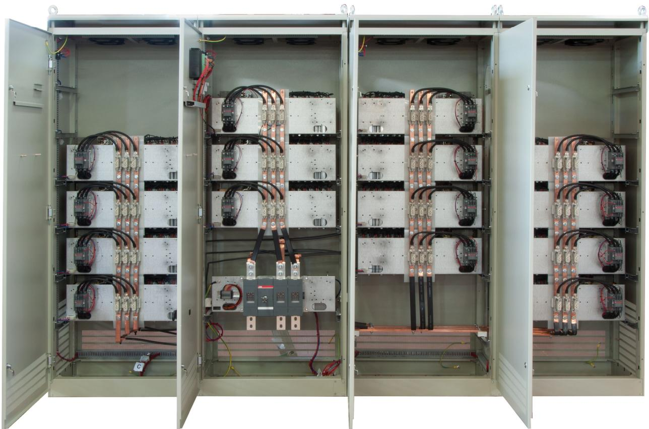
Foto dell'apparecchiatura AAR/D20 1150 kvar installata
